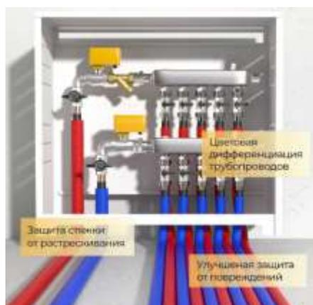
Трубки Energoflex Super Protect разработаны специально для изоляции труб отопления и водоснабжения, прокладываемых в конструкциях полов и стен.
